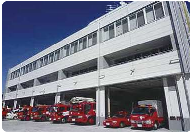
沼津市北消防署〈沼津市〉
